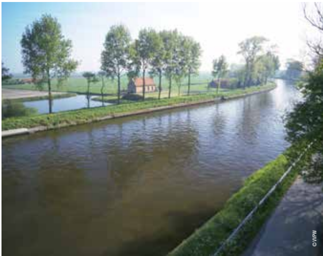
Pompgemaal De Steger (Nieuwe Polder van Blankenberge), met zijn wachtbekken en het ontvangende kanaal.
