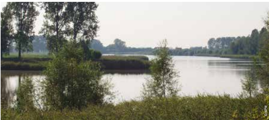
Restauratie en uitbreiding van het sluiswerk van de Schemelbertmolen, met visdoorgang (Polder Vliet en Zielbeek) in Liezele – Puurs.
